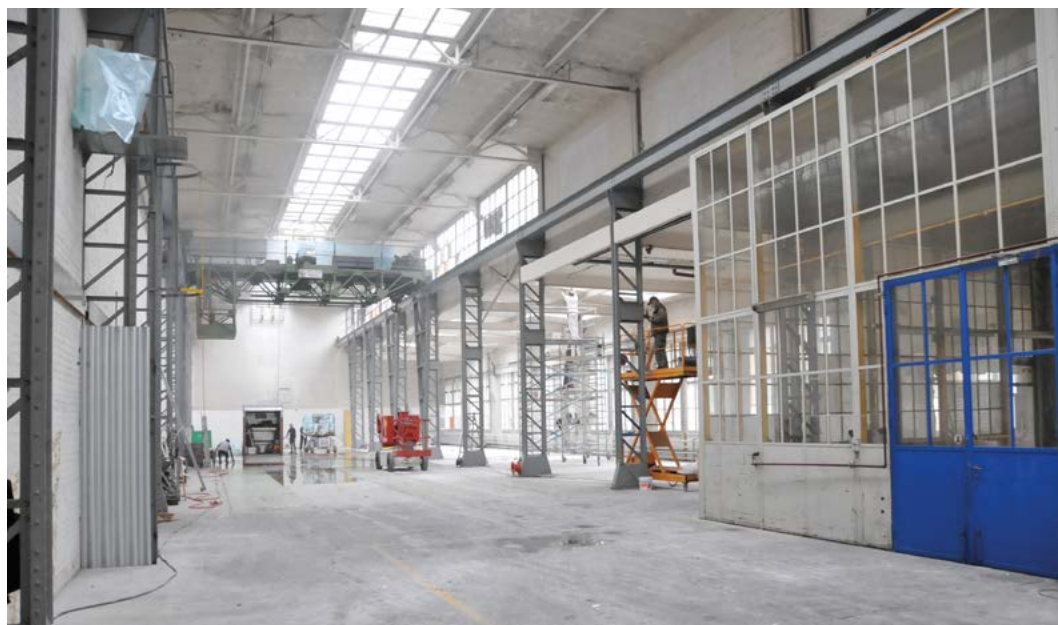
Die ehemalige Giesserei der Maschinenfabrik Burckhardt. Vor dem Verkauf an die Gundeldinger Feld Immobilien AG diente sie als Hochregallager, anschliessend wurde sie von Künstlern und Kleingewerbetreibenden zwischengenutzt.
