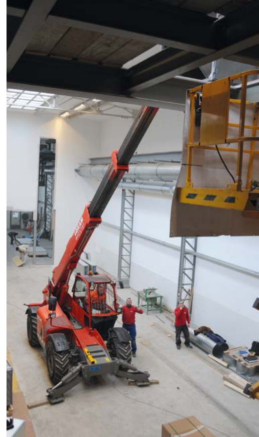
Montage der grossen Lüftungsanlage. Das CO 2 , das bei der Gärung entsteht, muss abgezogen werden. Bild oben: Installation der grossen Flaschenwaschmaschine.
